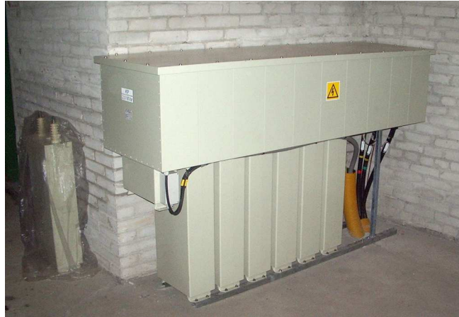
Joonis 4.44 Keskpingevõrgu paigaldatud kondensaatorpatarei
