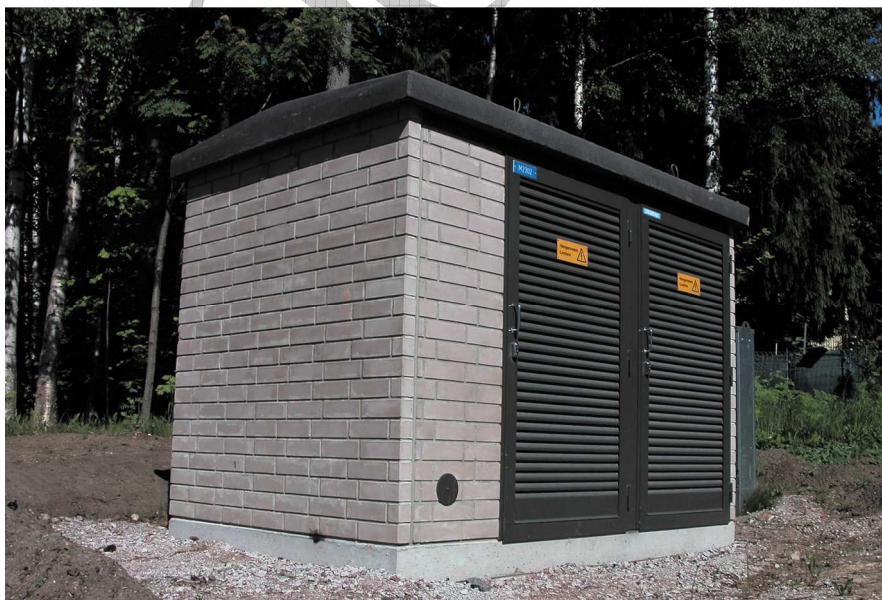
Joonis 4.33 Keskpingevõrgu jaotusalajaam
