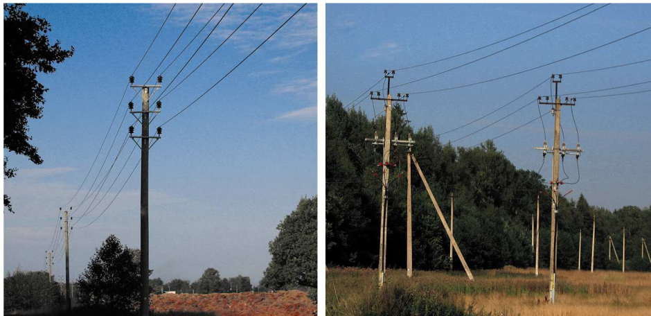
Joonis 4.15 Isoleerjuhtmetega ja paljasjuhtmetega keskpingeõhuliin
