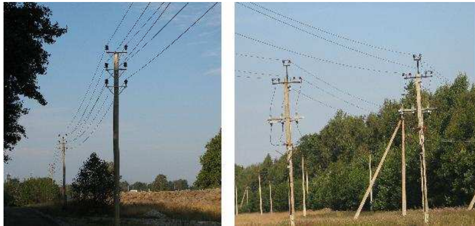
Joonis 5.16 Isoleerjuhtmetega ja paljasjuhtmetega keskpingeõhuliin
