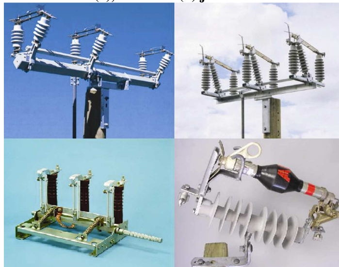
Joonis 5.29 Keskpinge võrkude kommutatsiooniseadmeid
