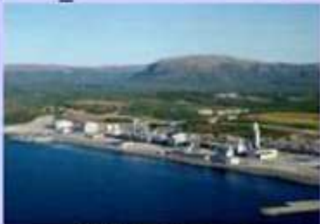
NH 3 , H 2 og gasification plants
